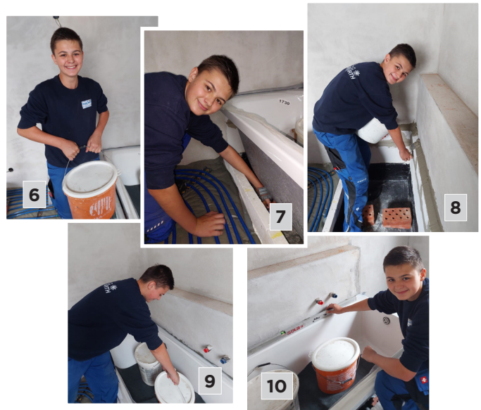
Bild 1 – 5: Verlegung von Fußbodenheizungsrohren Bild 6 – 10: Aufstellung der Badewanne
